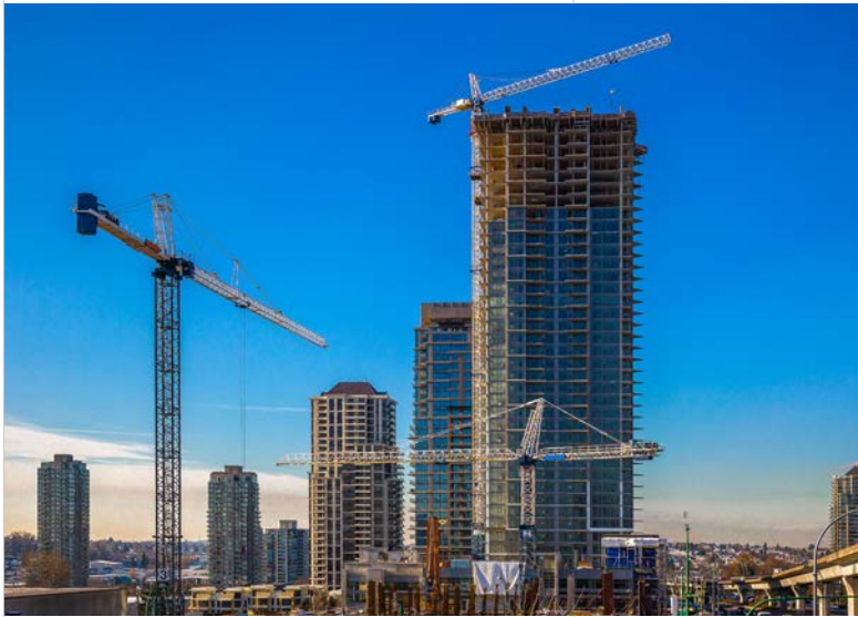
Nouvelle construction d'immeubles de grande hauteur à Burnaby, Vancouver
