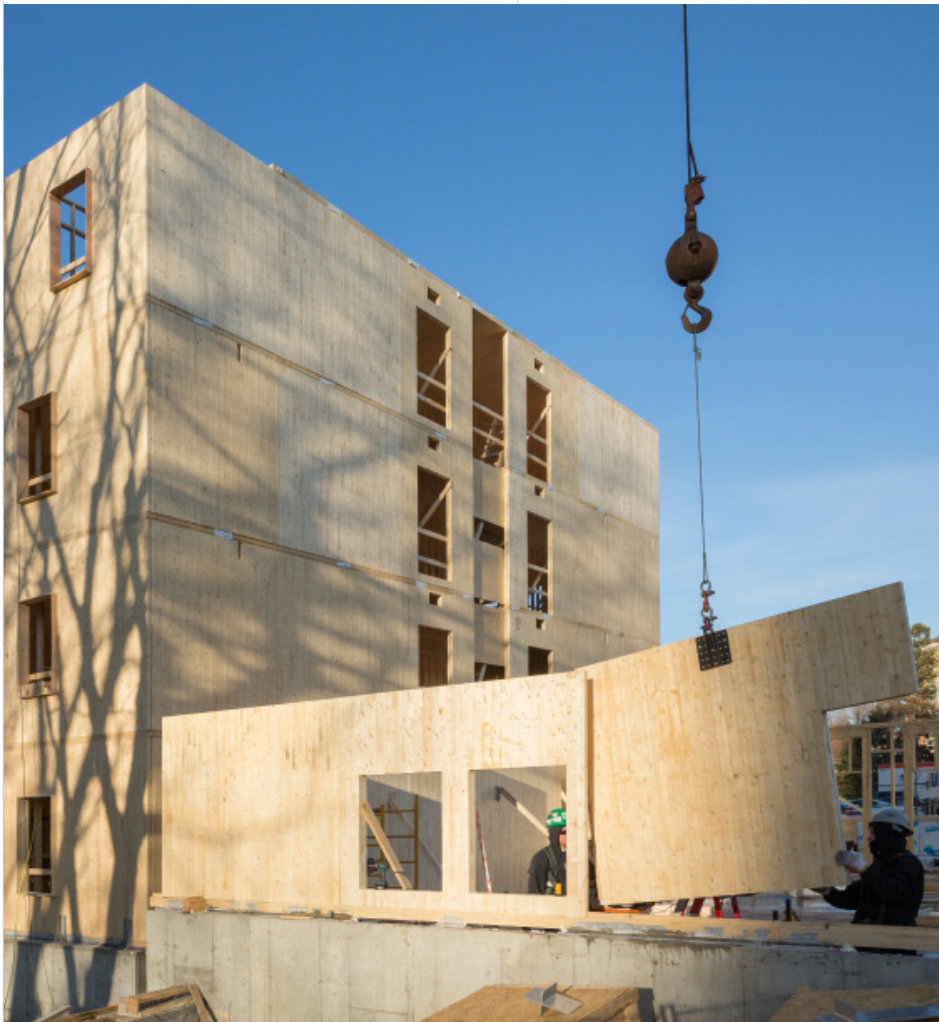
FIG 1: Installation d'un panneau ouvert. 70
