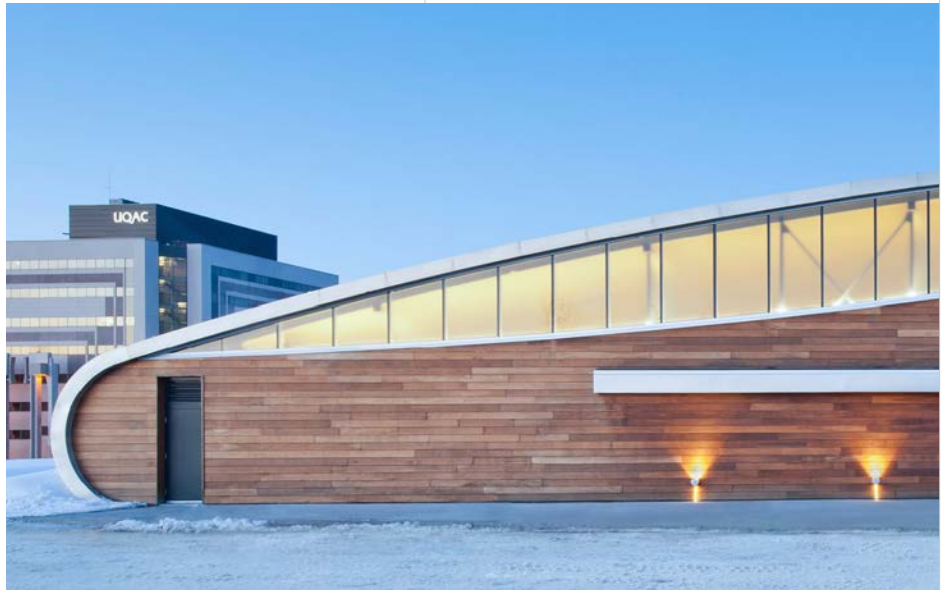
Aréna de l'UQAC, Université du Québec à Chicoutimi Chicoutimi, Québec Source: Nordic Structures
