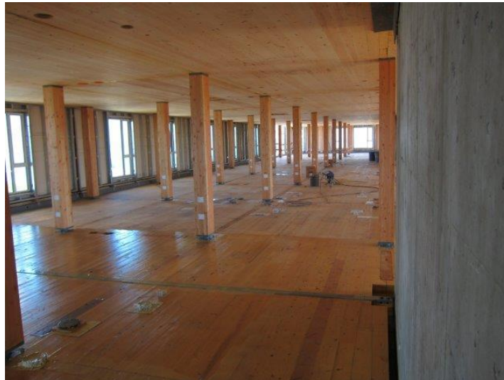
Brock Commons – glulam columns + CLT floor
