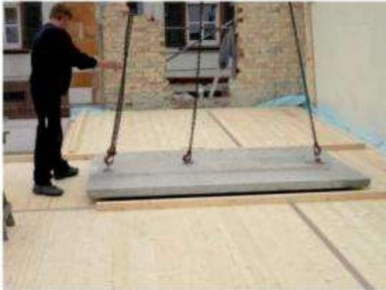
Vor-Ort-Verschraubung mit Stahlbetonfertigteilelementen
