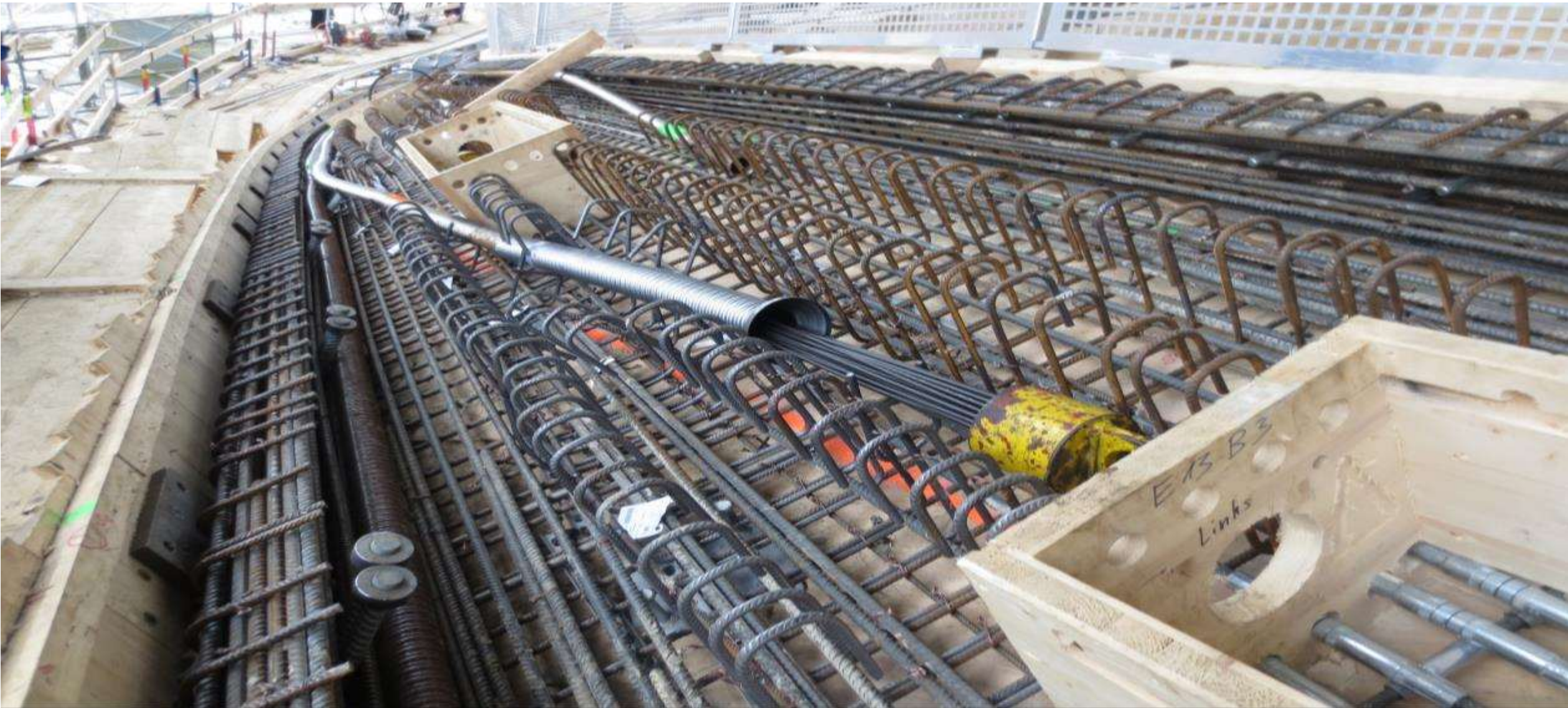
Vorspannung Ringbalken
