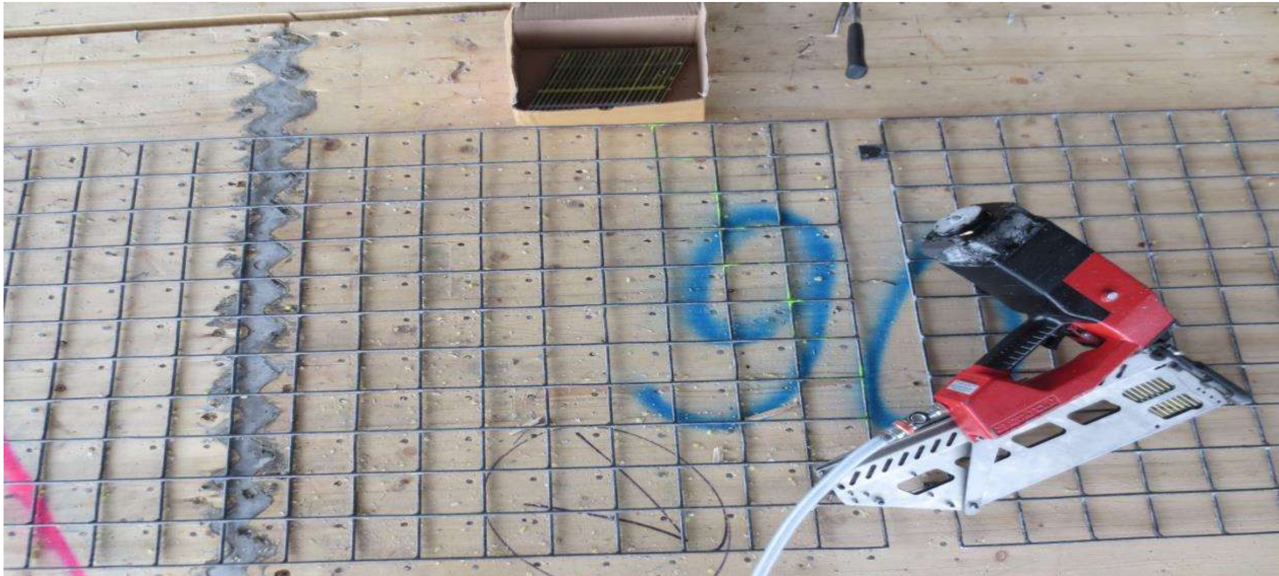
Flächige Nagelverbindung
